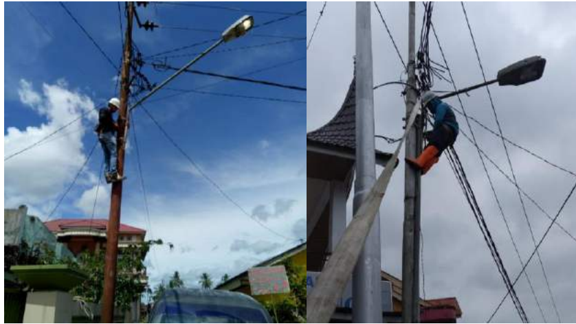
Gambar III. 6 Pmeliharaan Penerangan Jalan Umum (PJU)
