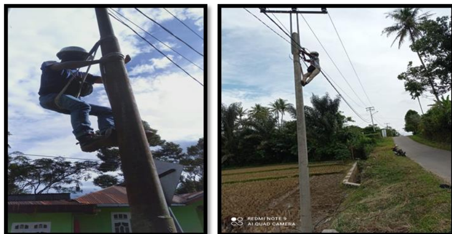
Gambar III. 6 Pemeliharaan Penerangan Jalan Umum (PJU)
