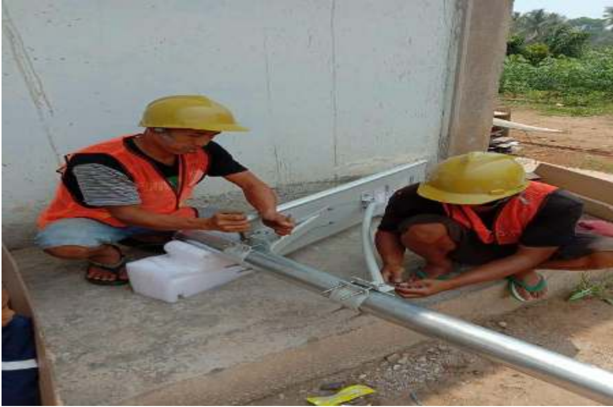
PROSES PEMASANGAN TIANG LAMPU PJU SOLAR CELL ALL IN ONE 40 WP PADA NAGARI KOTO TANGAH BATU AMPA ( Jrg Piladang Simp BR ) KECAMATAN AKABILURU
