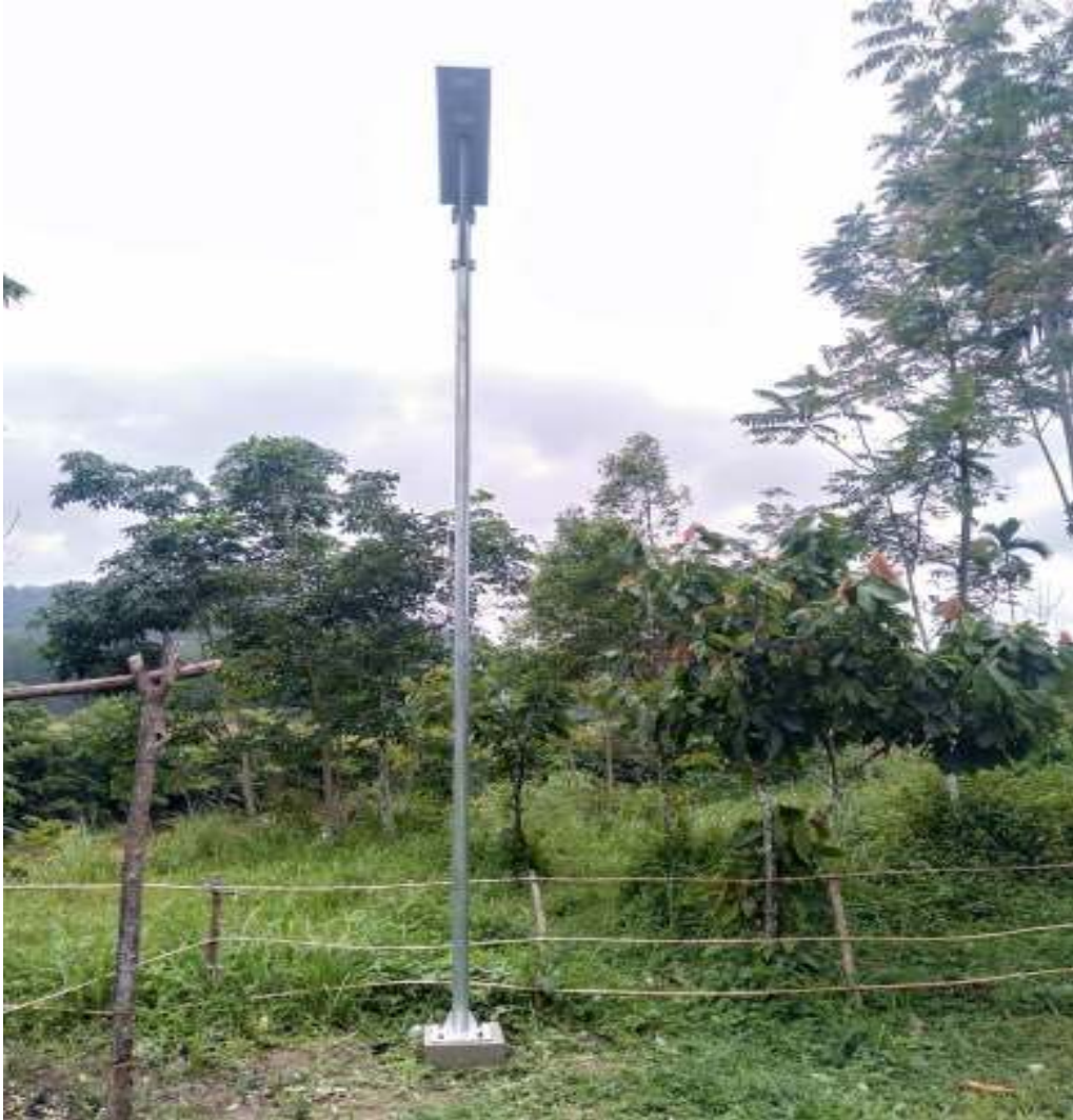
LAMPU PJU SOLAR CELL ALL IN ONE 40 WP LENGKAP TERPASANG PADA OBJEK WISATA KAPALO BANDA TARAM
