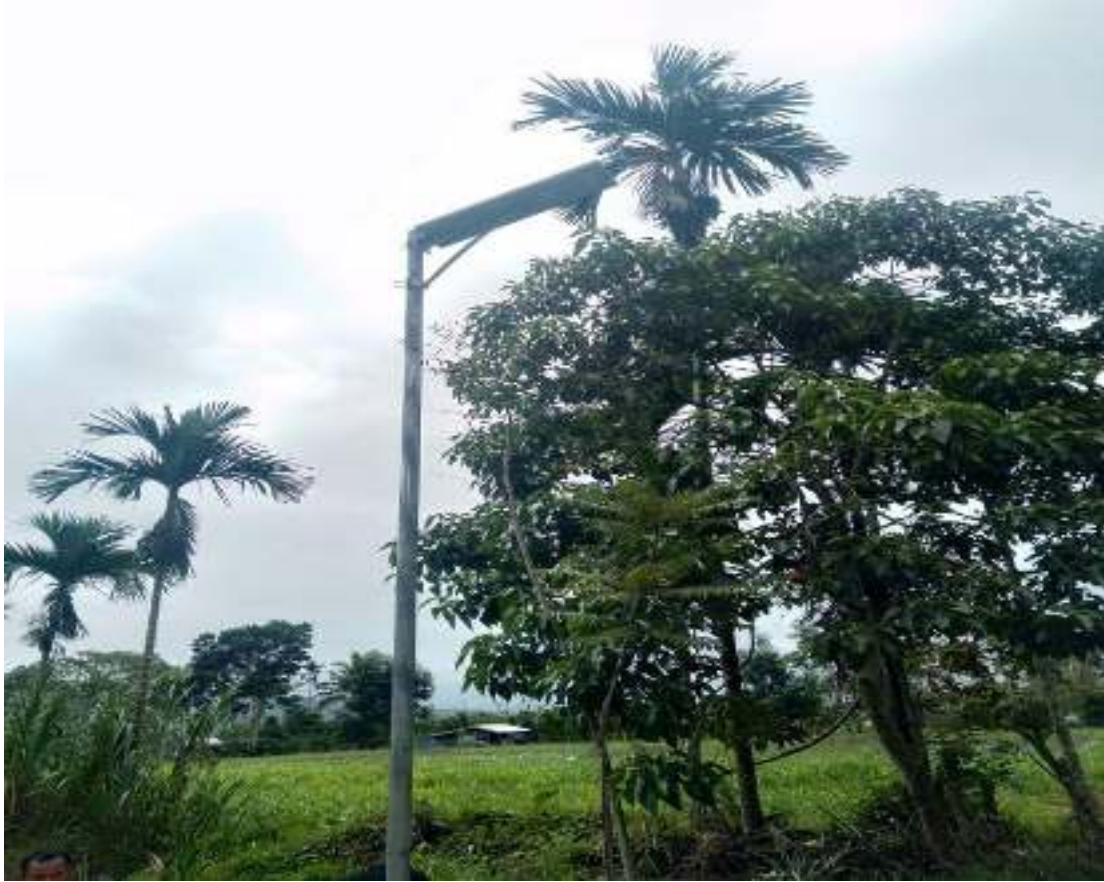
LAMPU PJU SOLAR CELL ALL IN ONE 40 WP LENGKAP TERPASANG PADA OBJEK WISATA KAPALO BANDA TARAM
