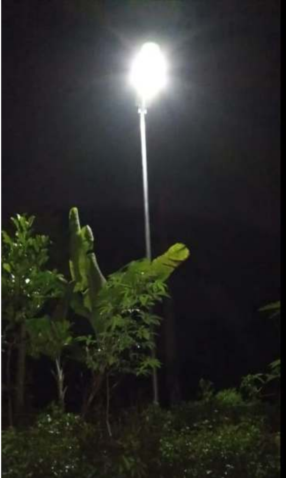
LAMPU PJU SOLAR CELL ALL IN ONE 40 WP LENGKAP TERPASANG PADA JORONG PADANG PARIK PANJANG NAGARI TAEH BARUAH KEC.PAYAKUMBUH
