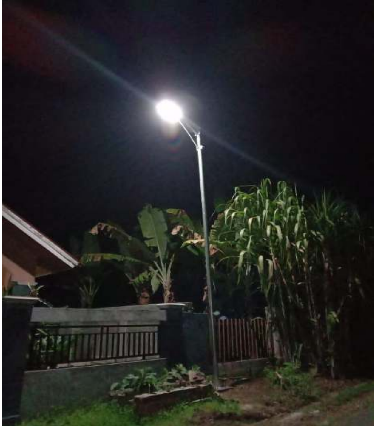
LAMPU PJU SOLAR CELL ALL IN ONE 40 WP LENGKAP TERPASANG PADA NAGARI KOTO TANGAH BATU AMPA ( Jrg Piladang Simp BR ) KECAMATAN AKABILURU
