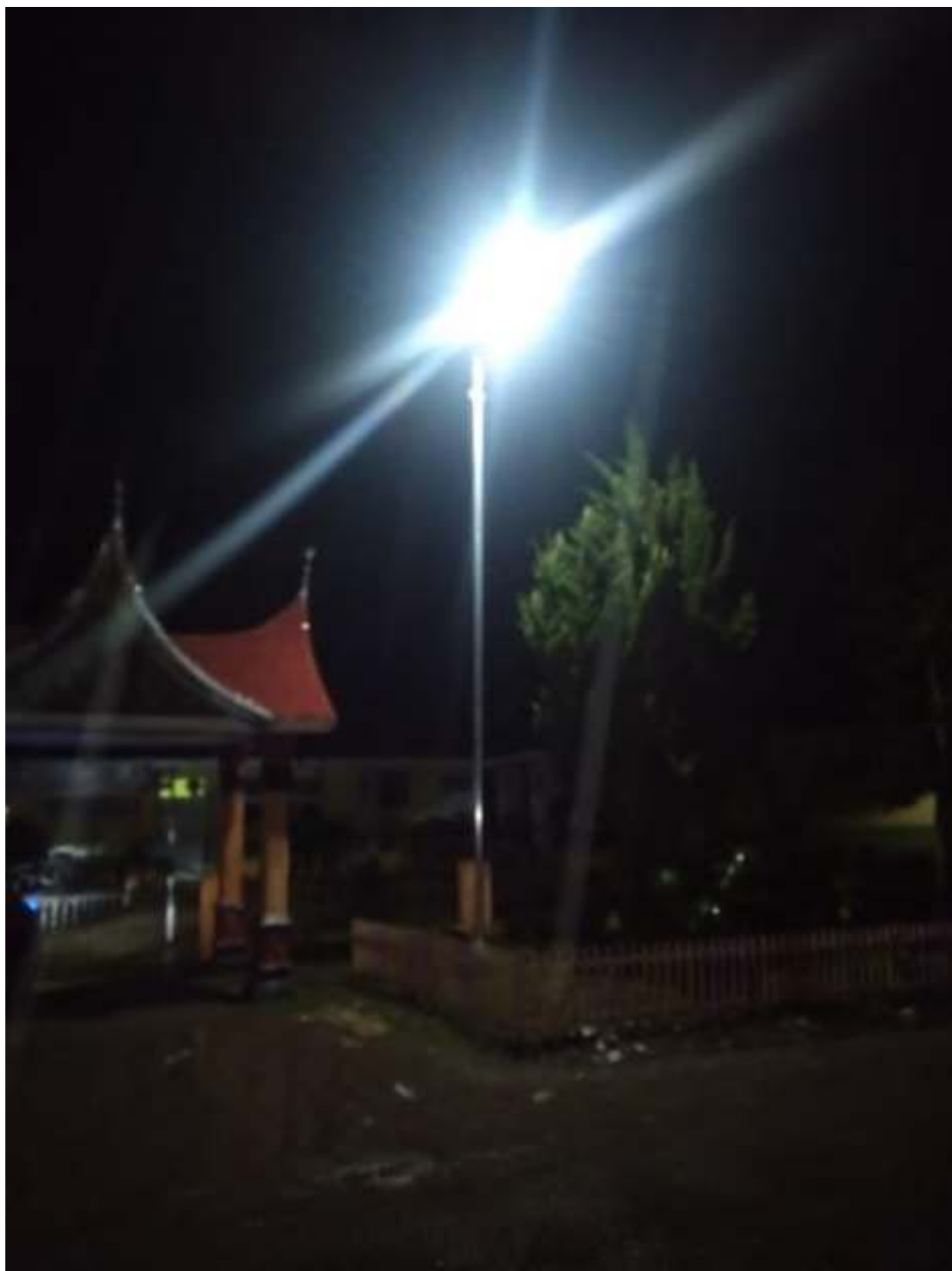
LAMPU PJU SOLAR CELL ALL IN ONE 40 WP LENGKAP TERPASANG PADA NAGARI SUNGAI BARINGIN KEC.PAYAKUMBUH
