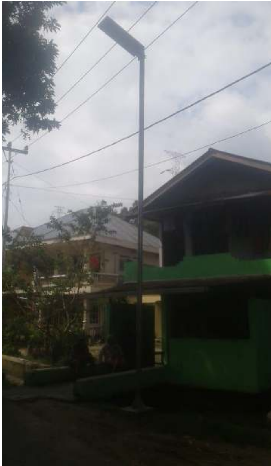
LAMPU PJU SOLAR CELL ALL IN ONE 40 WP LENGKAP TERPASANG PADA KOTO TANGAH BATU AMPA ( JR.TAMBUN IJUK/TANYUAH )KEC.AKABILURU
