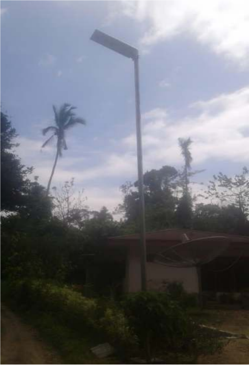
LAMPU PJU SOLAR CELL ALL IN ONE 40 WP LENGKAP TERPASANG PADA JORONG SUBARANG AIE NAGARI BATU PAYUANG KECAMATAN LAREH SAGO HALABAN
