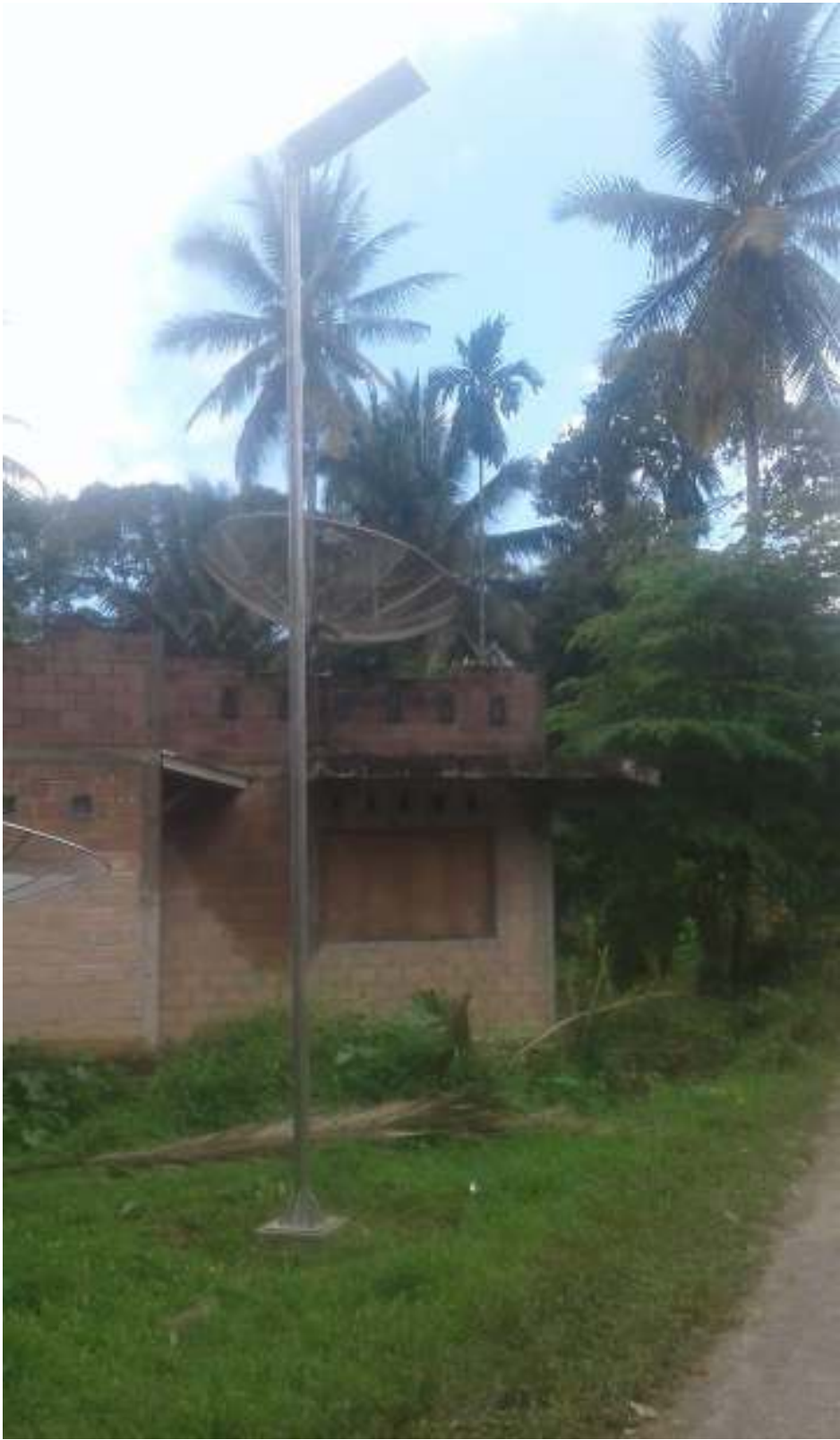
LAMPU PJU SOLAR CELL ALL IN ONE 40 WP LENGKAP TERPASANG PADA JORONG SUBARANG AIE NAGARI BATU PAYUANG KECAMATAN LAREH SAGO HALABAN
