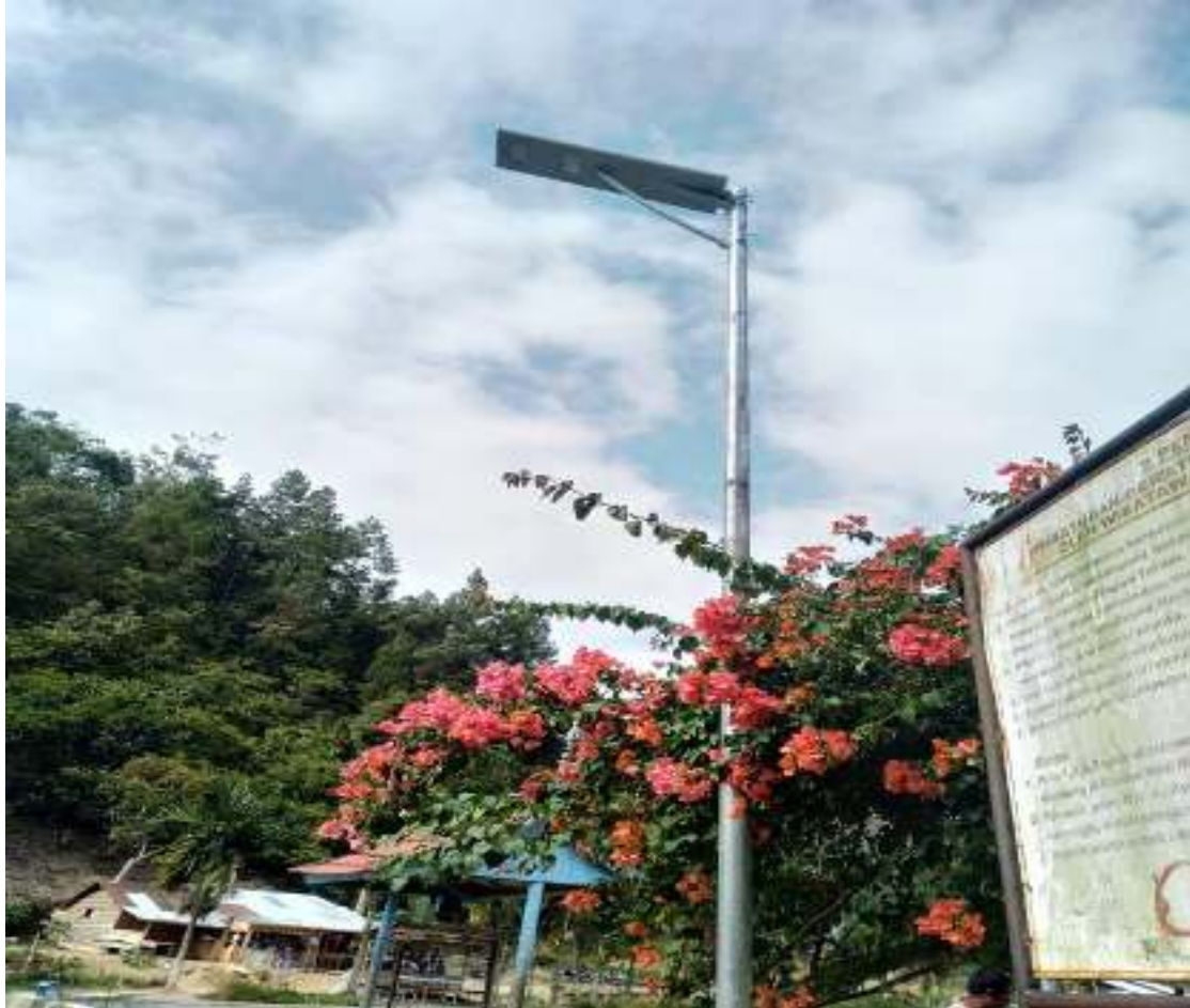
LAMPU PJU SOLAR CELL ALL IN ONE 40 WP LENGKAP TERPASANG PADA OBJEK WISATA KAPALO BANDA TARAM
