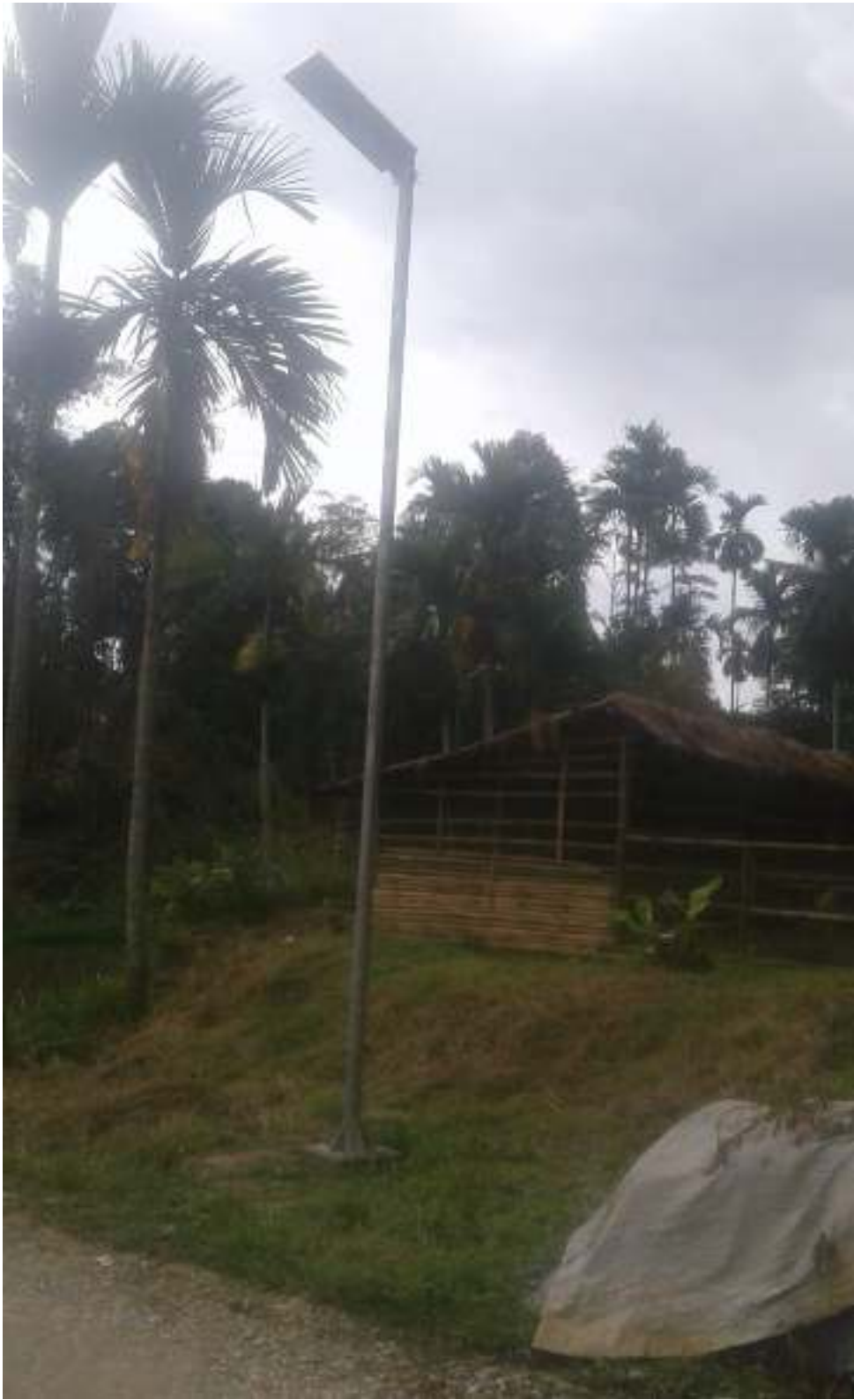
LAMPU PJU SOLAR CELL ALL IN ONE 40 WP LENGKAP TERPASANG PADA JORONG SUBARANG AIE NAGARI BATU PAYUANG KECAMATAN LAREH SAGO HALABAN
