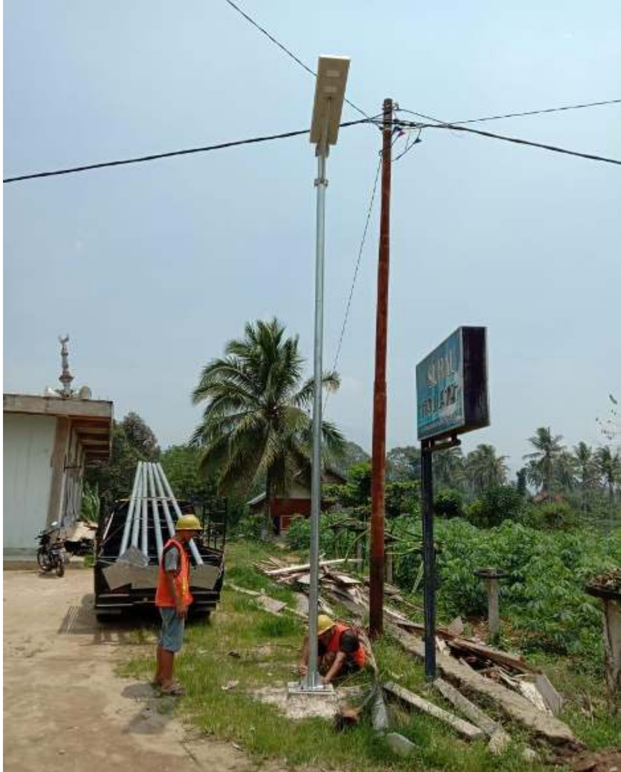
LAMPU PJU SOLAR CELL ALL IN ONE 40 WP LENGKAP TERPASANG PADA NAGARI KOTO TANGAH BATU AMPA ( Jrg Piladang Simp BR ) KECAMATAN AKABILURU
