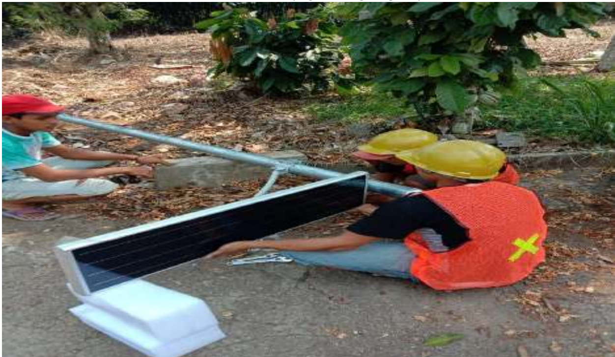
PROSES PEMASANGAN TIANG LAMPU PJU SOLAR CELL ALL IN ONE 40 WP PADA NAGARI KOTO TANGAH BATU AMPA ( Jrg Piladang Simp BR ) KECAMATAN AKABILURU
