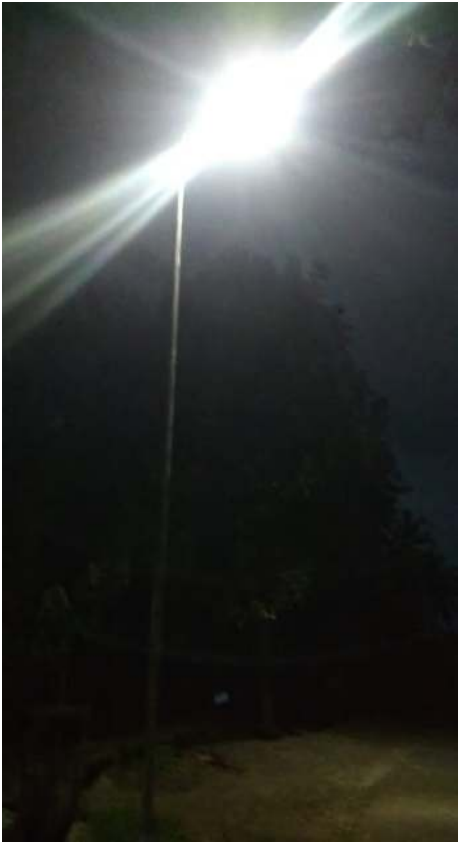
LAMPU PJU SOLAR CELL ALL IN ONE 40 WP LENGKAP TERPASANG PADA JORONG SUBARANG AIE NAGARI BATU PAYUANG KECAMATAN LAREH SAGO HALABAN
