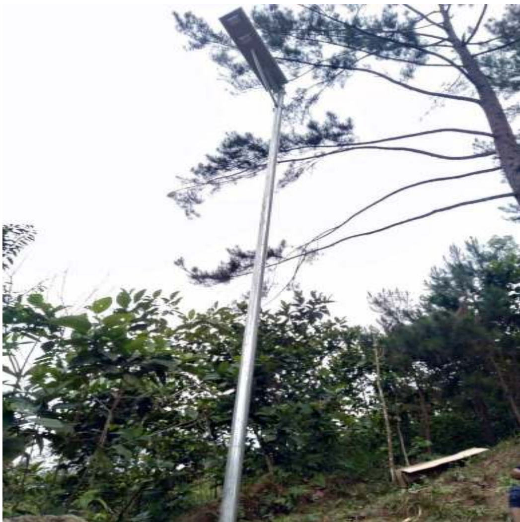
LAMPU PJU SOLAR CELL ALL IN ONE 40 WP LENGKAP TERPASANG PADA OBJEK WISATA KAPALO BANDA TARAM
