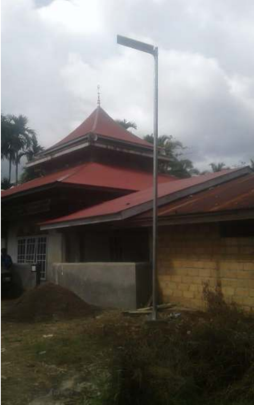
LAMPU PJU SOLAR CELL ALL IN ONE 40 WP LENGKAP TERPASANG PADA JORONG SUBARANG AIE NAGARI BATU PAYUANG KECAMATAN LAREH SAGO HALABAN
