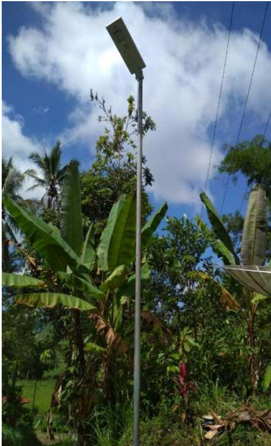
LAMPU PJU SOLAR CELL ALL IN ONE 40 WP LENGKAP TERPASANG PADA NAGARI KOTO TANGAH KECAMATAN BUKIT BARISAN
