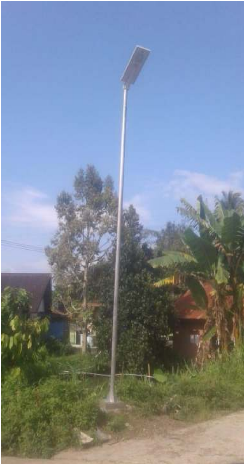
LAMPU PJU SOLAR CELL ALL IN ONE 40 WP LENGKAP TERPASANG PADA KOTO TANGAH BATU AMPA ( JR.TAMBUN IJUK/TANYUAH )KEC.AKABILURU
