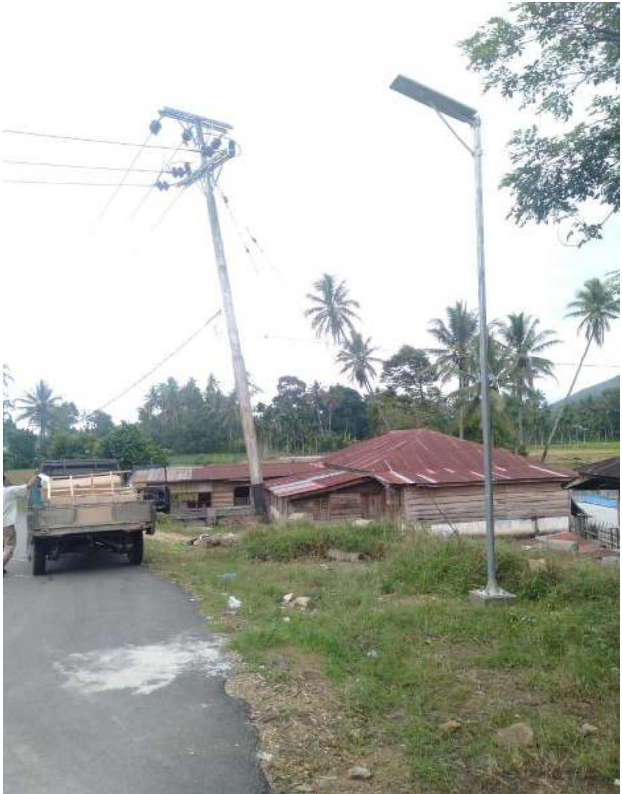
LAMPU PJU SOLAR CELL ALL IN ONE 40 WP LENGKAP TERPASANG PADA NAGARI SUNGAI BARINGIN KEC.PAYAKUMBUH
