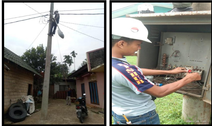
Gambar III. 8 Pemeliharaan Penerangan Jalan Umum (PJU)
